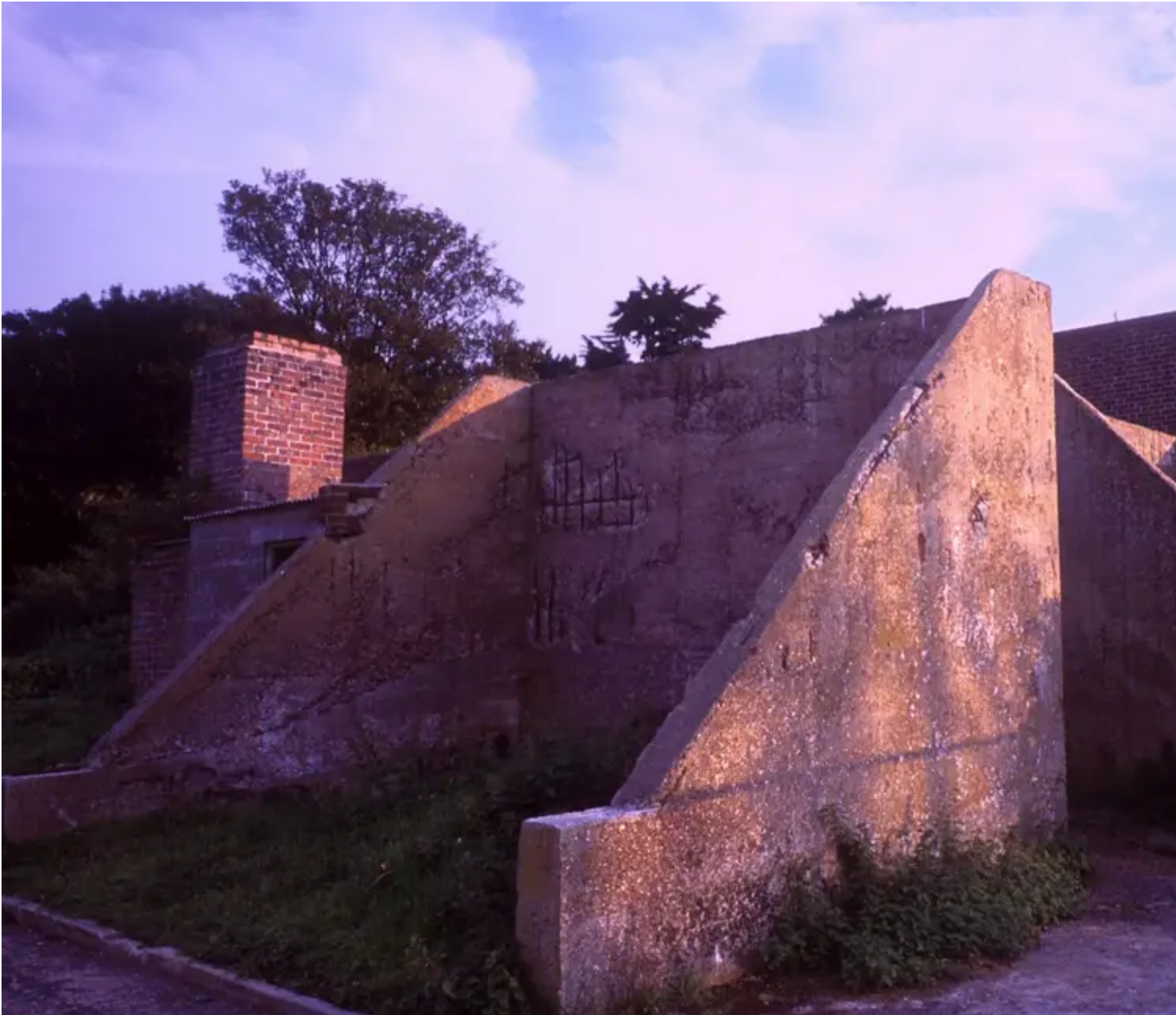
Bawdsey Transmitter Block
